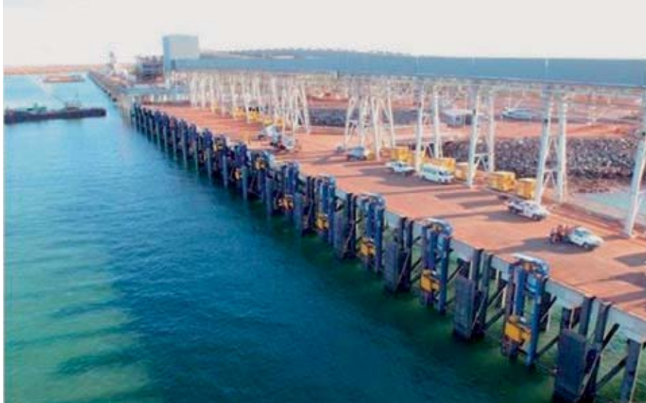
Unidades MoorMaster en el puerto de Hedland's Utah.
