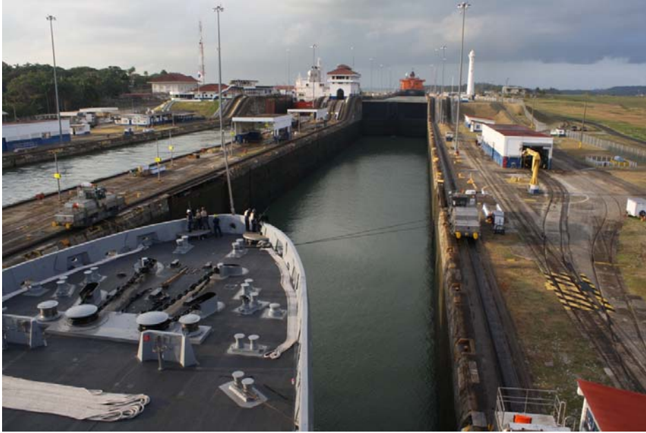
Figura 6 – Locomotoras remolcando un buque en una de las esclusas del canal de Panamá
