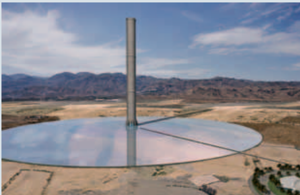
Representación artística de una torre solar. Estas instalaciones son muy elevadas, ocupan áreas muy extensas y su construcción es costosa, pero pueden llegar a generar electricidad a precios económicos.
